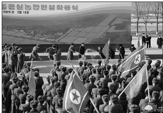
Първа копка на строежа на новия комплекс оранжерии край Пхенян
